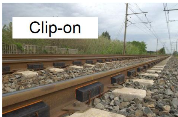
Figura nr 4: Amortizor de zgomot CORUS, aplicat
